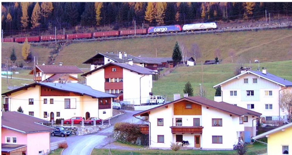
Fig. 4 Trois locomotives électriques, deux en traction et une en propulsion, sont nécessaires pour mettre en branle les wagons de ce train de fret engagé dans une forte pente ascendante en direction du passage Brenner aux environs du village de St. Jodok/Tyrol.
